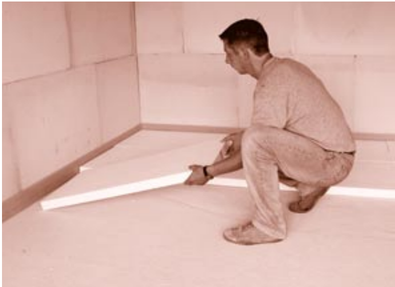
Plaatsing EPS-T in de woningbouw.
